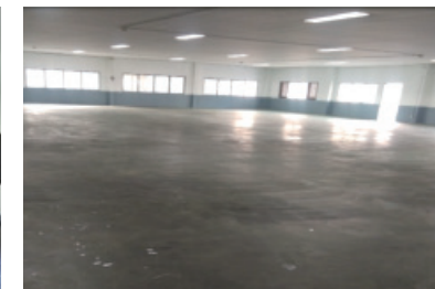
一般保管用スペース AIR CONDITIONER CONTROL ROOM
